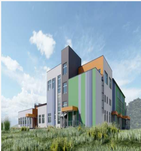
Строительство школы в п.Вишневогорск
