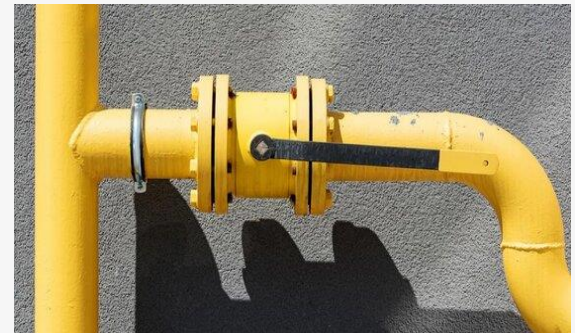
Строительство газопровода Огнево-Багаряк
