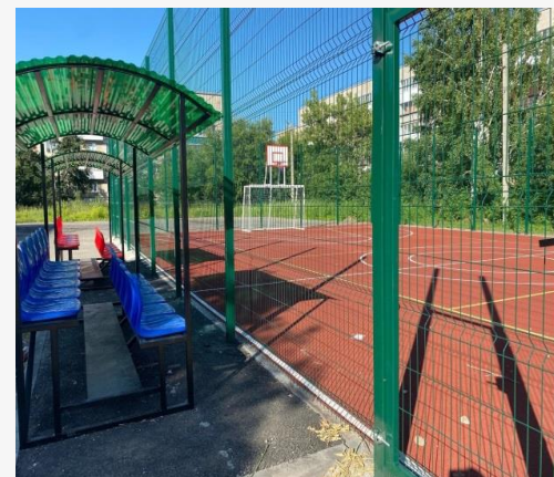
Строительство многофункциональных спортивных площадок во всех центральных усадьбах
