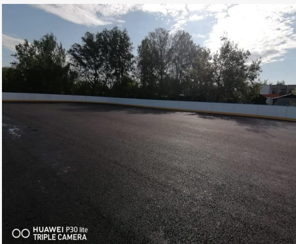
Строительство хоккейного корта в п. Береговой
